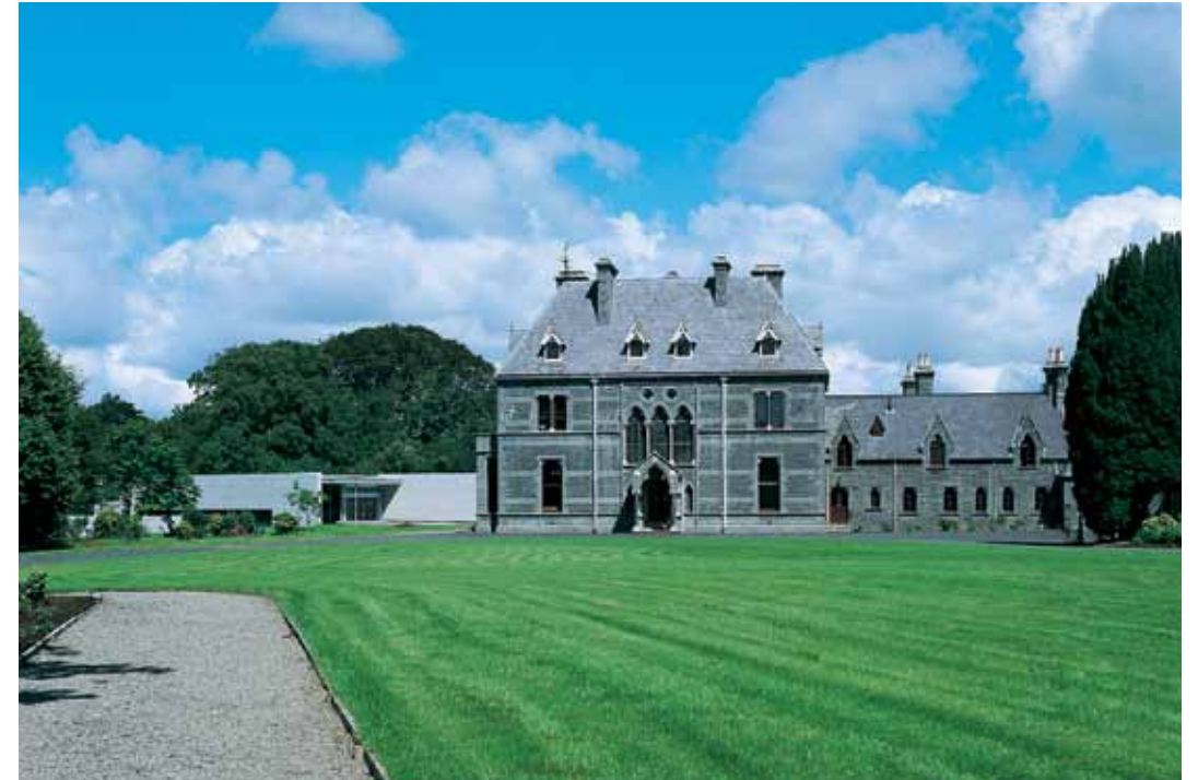
Turlough Park House, construite en 1865, avec des galeries d'exposition modernes, spécialement conçues, à l'arrière plan
